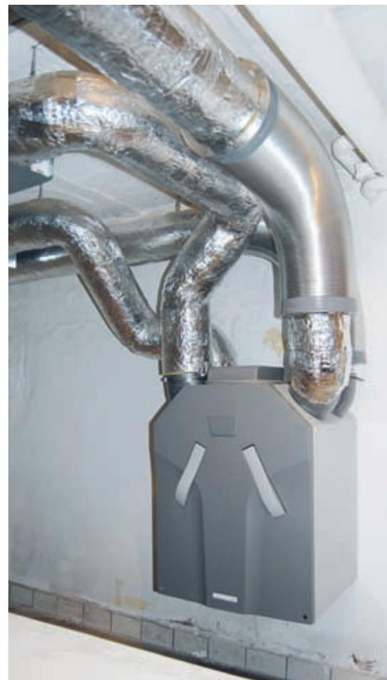
(5) Ein Lüftungsgerät im Keller eines energetisch sanierten Einfamilienhauses. Es enthält zwei Ventilatoren und einen Wärmetauscher für die Wärme- und Feuchterückgewinnung.
